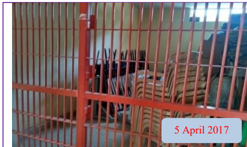
ಶಿವಮೊಗ್ಗ ನಗರದ ದೊಡ್ಡಪೇಟೆ ಪೊಲೀಸ್ ಠಾಣೆಯಲ್ಲಿ ಮಹಿಳಾ ಲಾಕಪ್ ಕೊಠಡಿಯನ್ನು ಆಯುಧಗಳು ಮತ್ತು ದಾಖಲೆಗಳನ್ನು ದಾಸ್ತಾನು ಮಾಡಲು ಉಪಯೋಗಿಸಲಾಗುತ್ತಿತ್ತು
